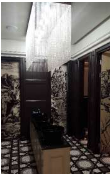
Фото 27. Состояние помещений 1 этажа
