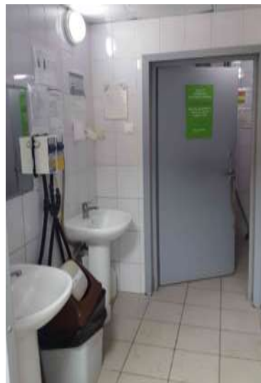
Фото 10. Состояние помещений цокольного этажа
