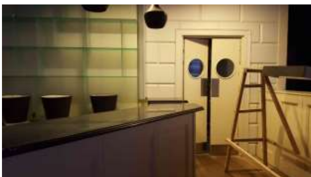
Фото 23. Состояние помещений 1 этажа
