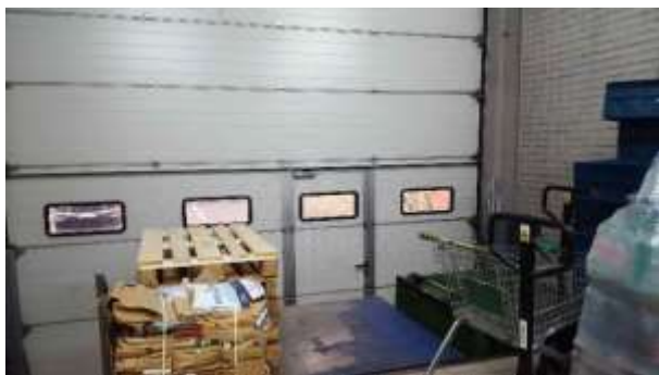
Фото 19. Состояние помещений 1 этажа
