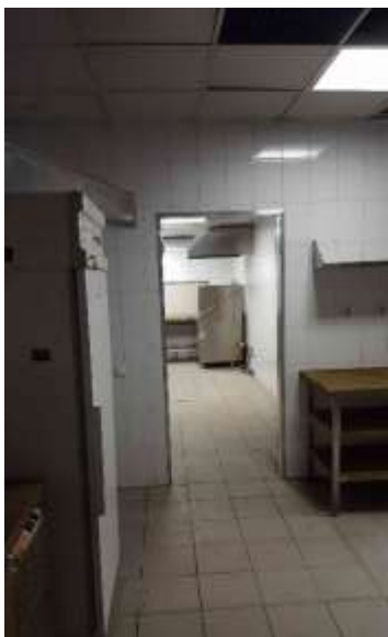
Фото 25. Состояние помещений 1 этажа
