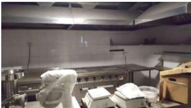
Фото 21. Состояние помещений 1 этажа
