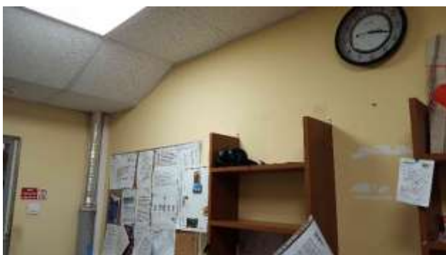
Фото 7. Состояние помещений цокольного этажа
