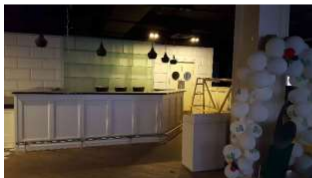
Фото 24. Состояние помещений 1 этажа
