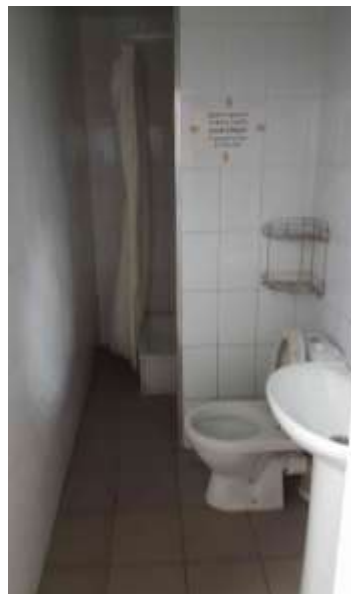
Фото 26. Состояние помещений 1 этажа
