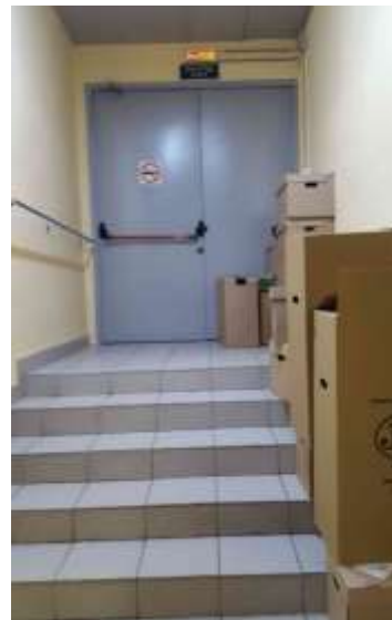
Фото 14. Состояние помещений 1 этажа
