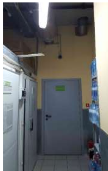
Фото 16. Состояние помещений 1 этажа
