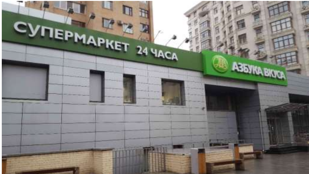
Фото 1. Внешний вид здания
