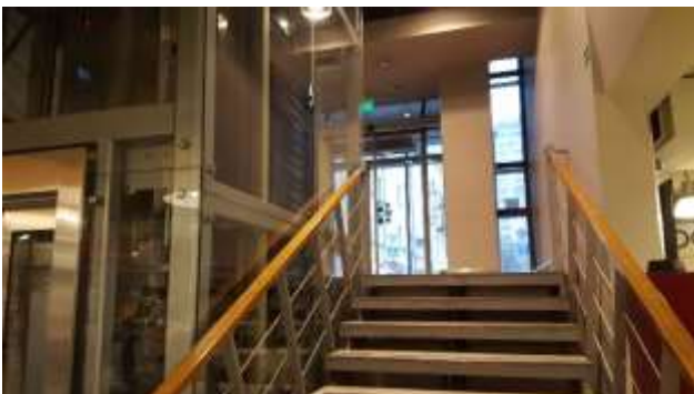
Фото 3. Состояние помещений цокольного этажа
